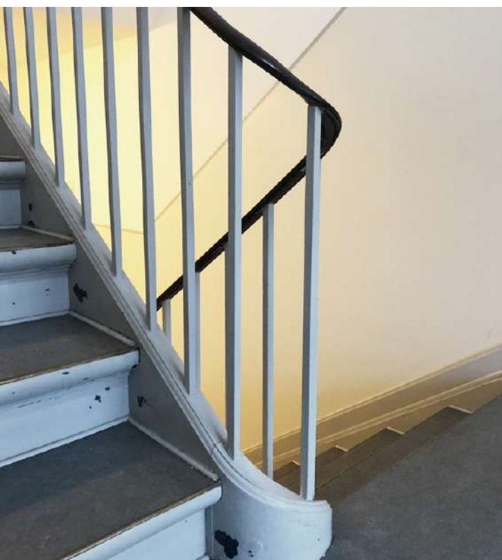
Typisk linoleum på trappe og repos
