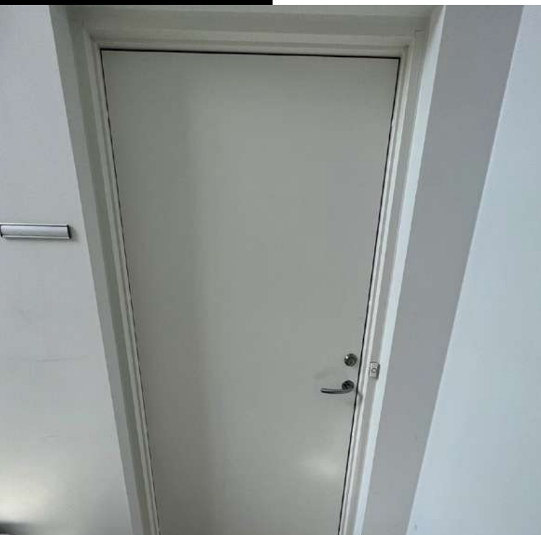
Typisk indfatning, lejlighedsdør
